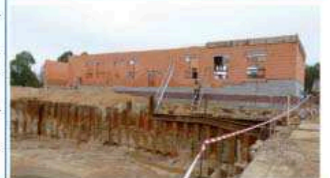
Foto: Roboty budowlane - teren oczyszczalni ścieków
